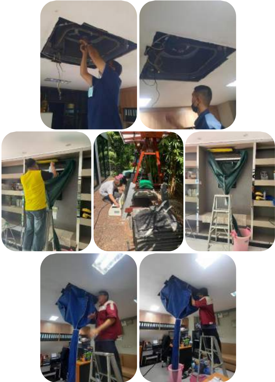
ภาพที่ 2-3.1.2(4) อนุรักษ์พลังงานโดยการล้างแผงกรองอากาศ และคอยล์ร้อนเป็นประจำ
