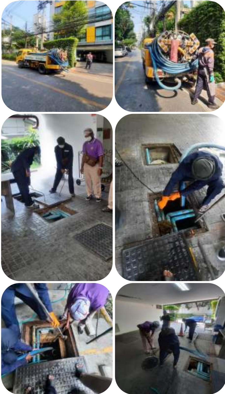
ภาพที่ 2-1.5(1) สูบน้ำบริเวณส่วนตะกอนบำบัดน้ำเสีย
