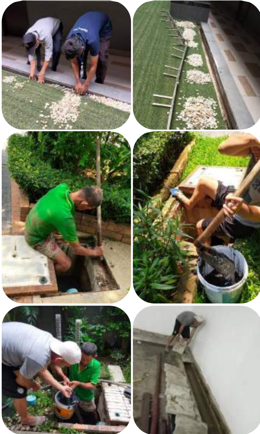
ภาพที่ 2-3.2(1) การขุดลอกท่อระบายน้ำ และตัดตะกอน
